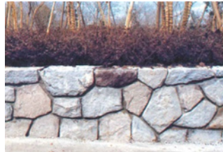
② 修景割石積み
