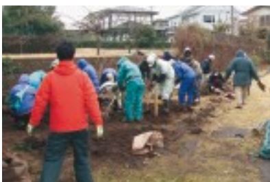
ビオトープ池の造成の施工を実施(ハーブ見本園)
