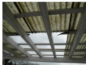
ルーバーの腐朽、破損
