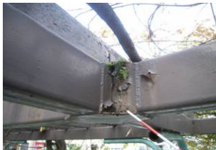
支柱部の腐食
