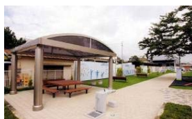
老朽化が進んだ公園施設を、高齢者にも使いやすいようにバリアフリー化するとともに、地域のニーズに合わせ再整備
