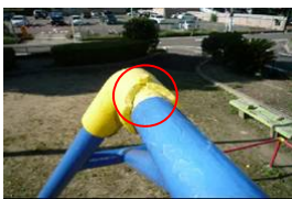
吊金具のずれ
