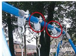
吊金具のずれ
