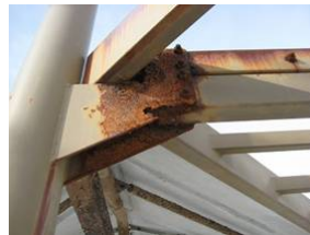
ルーバーの腐朽、破損
