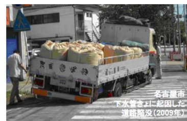
▲社会資本の老朽化による被害の例
