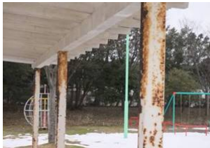
支柱部の腐食
