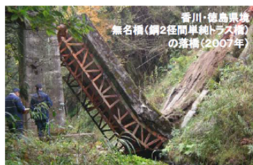
▲社会資本の老朽化による被害の例
