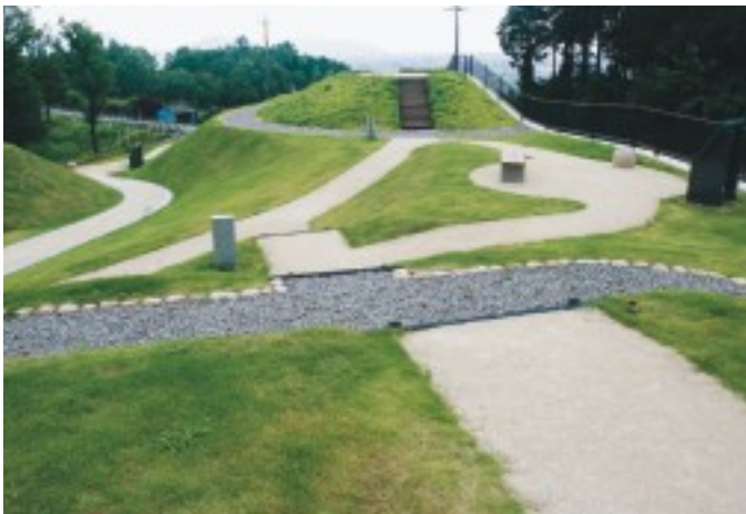
整備後(A地区) 古墳の一部が市道で削られていた為、市道側は擁壁とフェンスで仕切って古墳の姿を最大限に見せる工夫をした。急峻な地形だったが8%以内の勾配に抑えて周遊園路を配置した
