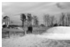
災害復旧工事で整備した箇所
