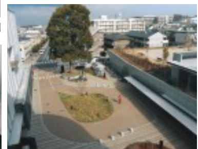
整然としたデザインのエントランス広場
