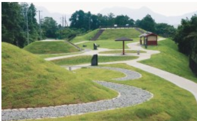
整備後(C地区) 古墳は覆土して保存、盛土の上に園地を整備した。トイレ、四阿は文化財包蔵地の指定区域外に新たに用地を確保して設置した
