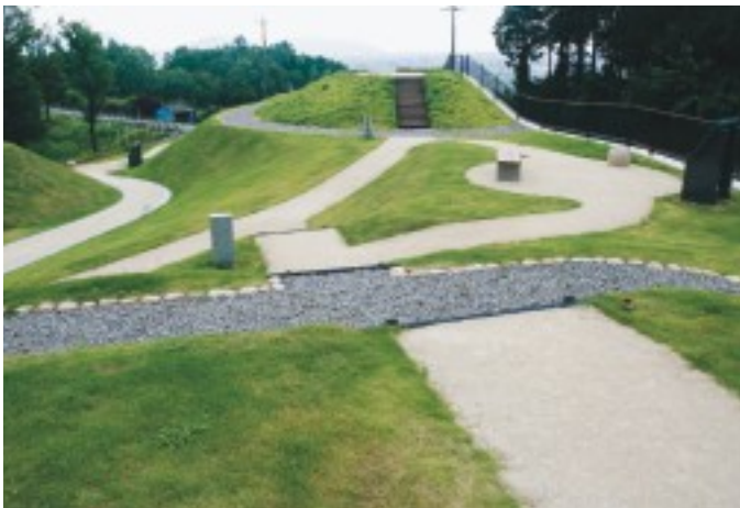
整備後(A地区) 古墳の一部が市道で削られていた為、市道側は擁壁とフェンスで仕切って古墳の姿を最大限に見せる工夫をした。急峻な地形だったが8%以内の勾配に抑えて周遊園路を配置した
