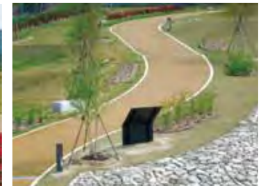
雨水貯留施設、園路、周溝の整備
