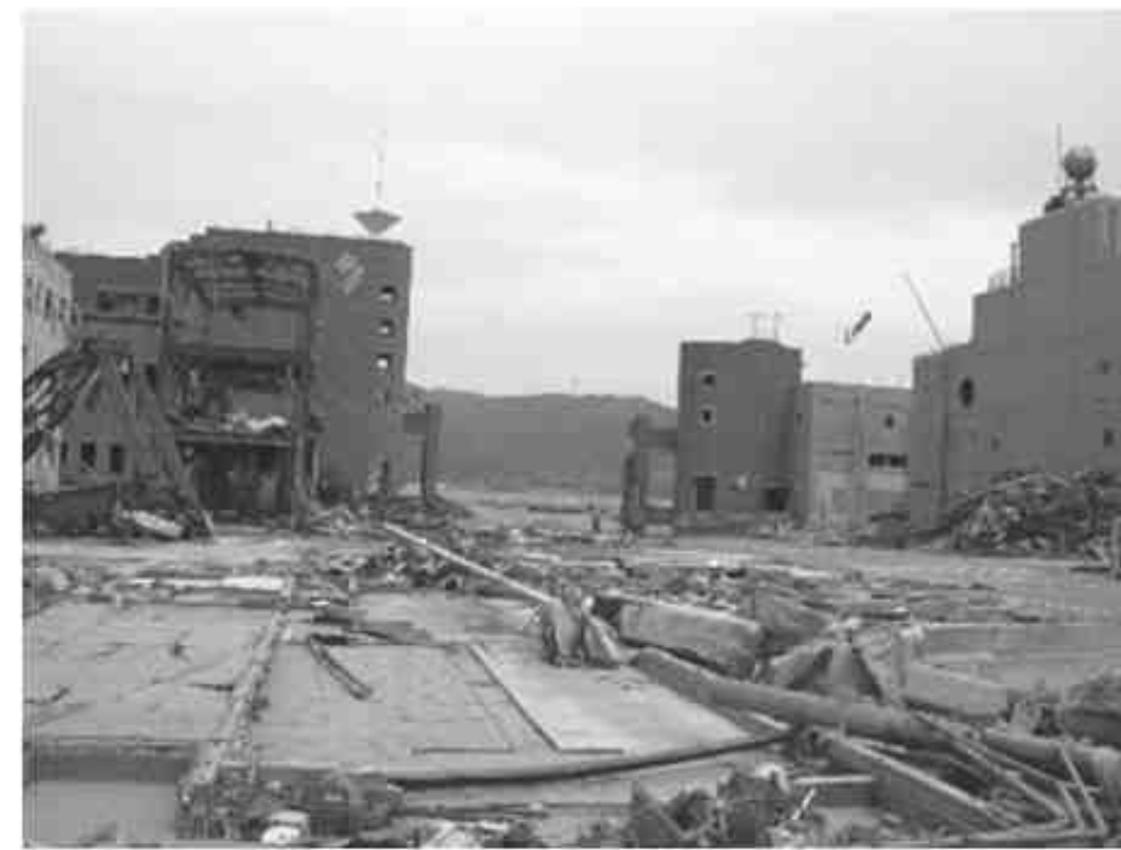
被害を受けた女川港・マリナビル
