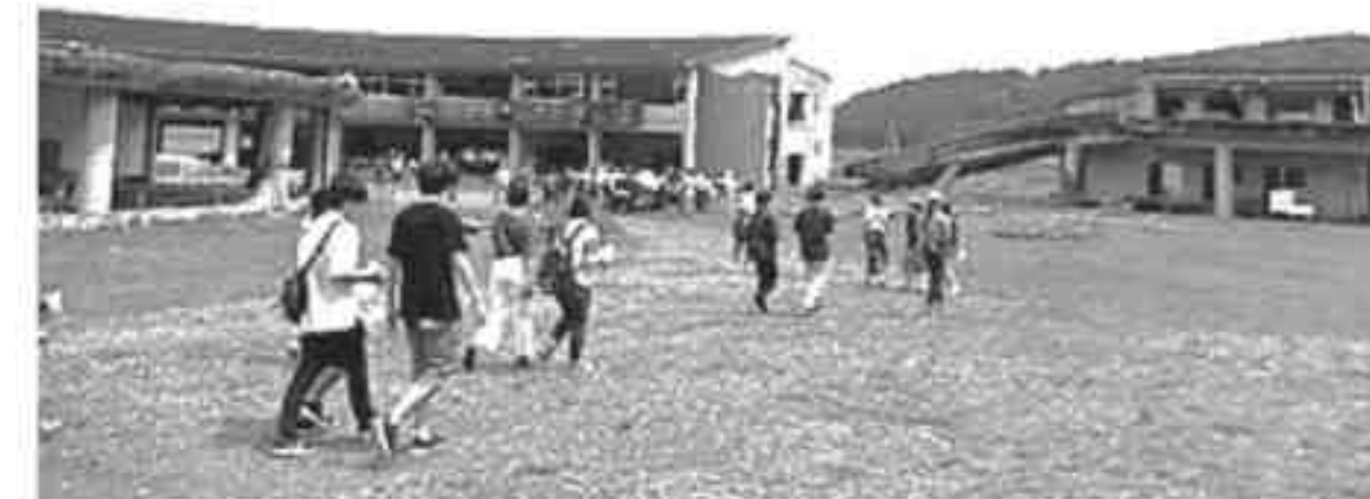
旧大川小学校の現在の状況
