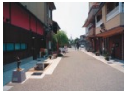
脱色アスファルトと自然石による舗装
