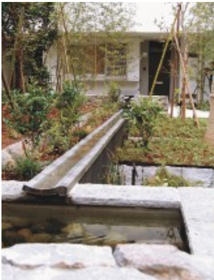
雨水利用の長い水路と水盤
