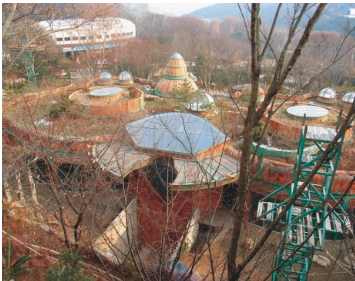
斜面に設置されたアプローチデッキからの全景
