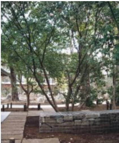
大谷石の端材を試験積みした後に廃材を充填したフトンカゴ雑石積
