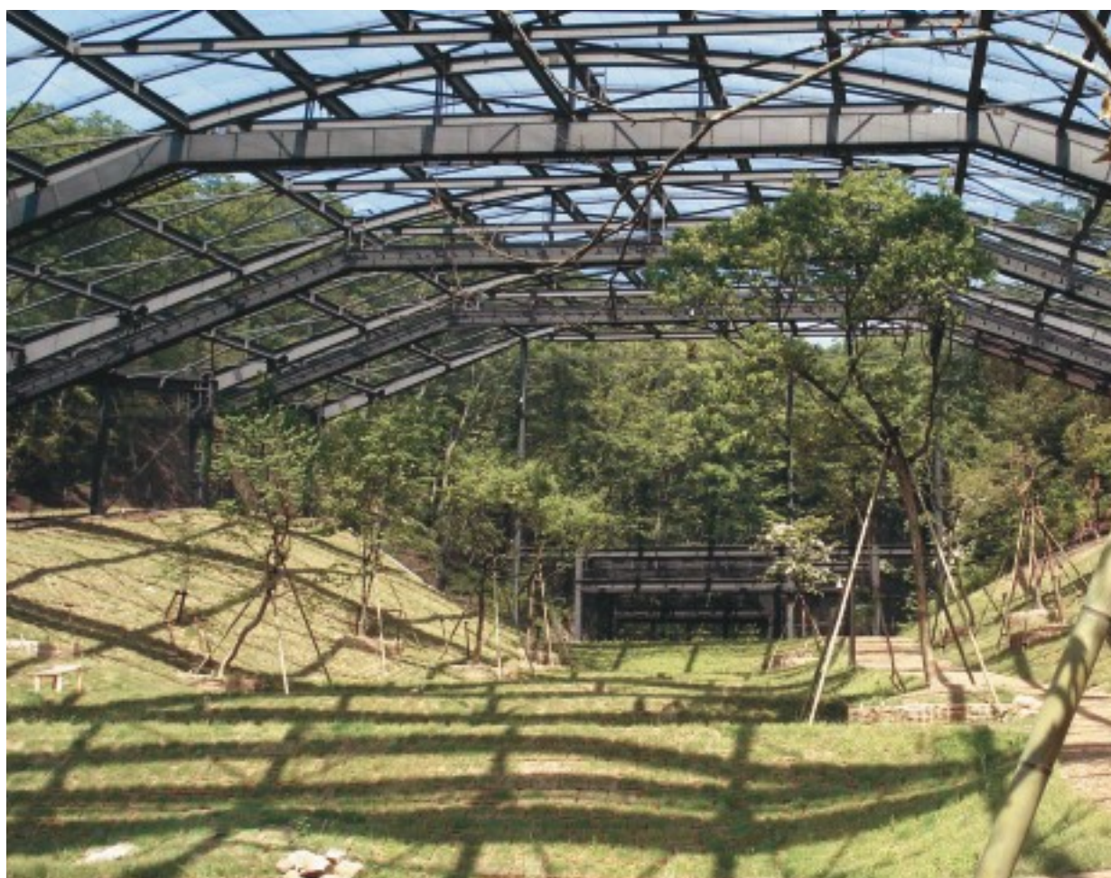
順化ケージ内部
