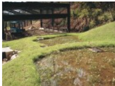
順化ケージ上流側湿地ビオトープ
