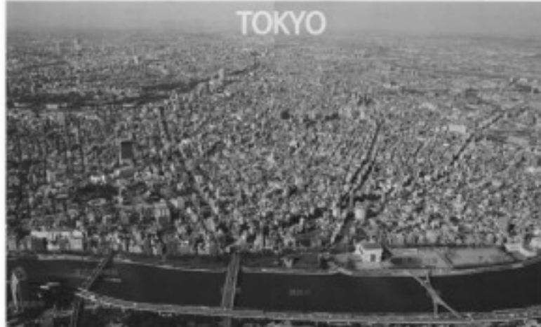
写真1 東京スカイツリーの建設位置における高さ610mからの眺望(北西方向) 出典「新下町景観 超天空610mに墨田に『東京スカイツリー』がそびえる日」,東京新聞編集局編、東京新聞出版局発行、2008年7月(撮影:空原和則)(東京新聞レポーターで撮影)
