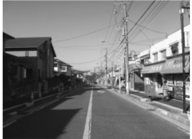
写真2 工事後：並木を持続するため伐採伐根・土壌改良・植樹前
