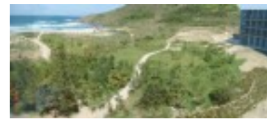
竣工時の状況
