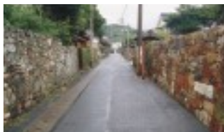
武家門と石塀を復旧し、武家屋敷通りの街なみの連続性を確保
