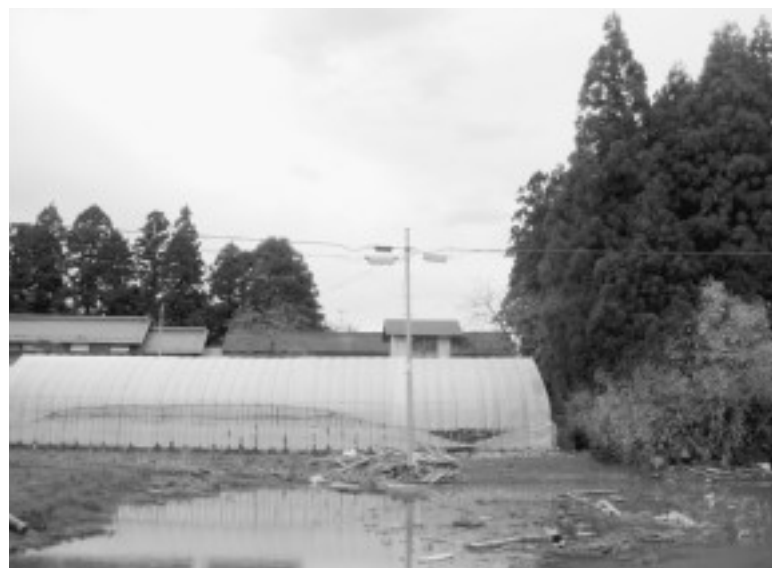
写真4 伝統的な屋敷林の居久根が津波を軽減した
