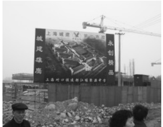
写真1 倒壊した中学校と復興支援の看板
