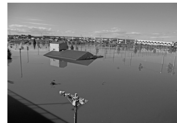
写真-2 越流時の冠水状況
